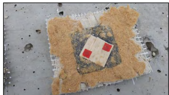
Abbildung 43: Entfernte Putzschicht der Variante N 2.3 (heller Putz) mit Balsasensor- und Holzfaserrückständen. Optisch ist kein Pilzmyzel erkennbar.
